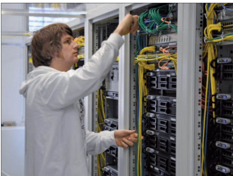
Wartungsarbeit im Rechenzentrum: Ein Mitarbeiter verkabelt einen Webserver.
